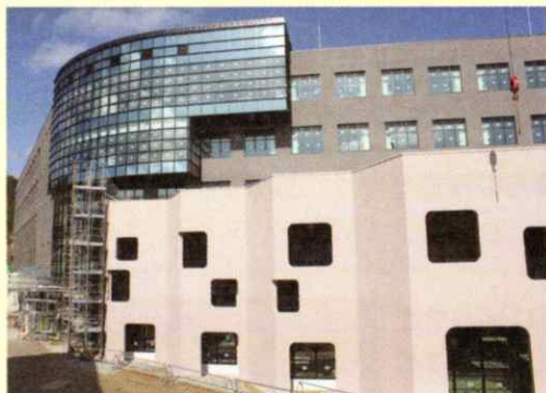
建設中の3号館
