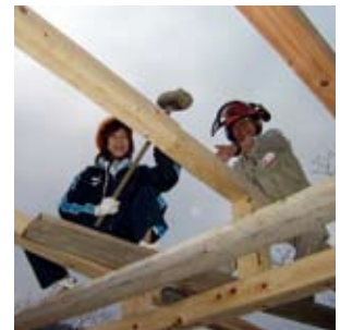
A 地域共生演習 阿武町「あったか村」棟上げ！
