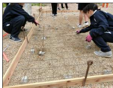
生コンクリート用の鉄筋敷設
